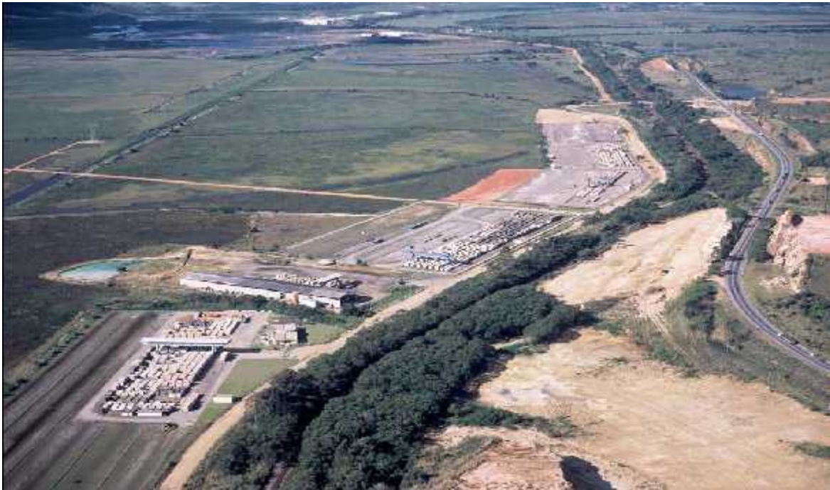
Foto 3: Vista aérea do Pólo Jacuhy
