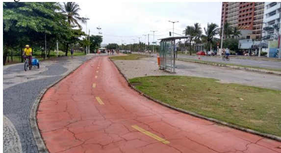
Figura 14. Trecho de ciclovia com rachadura.
