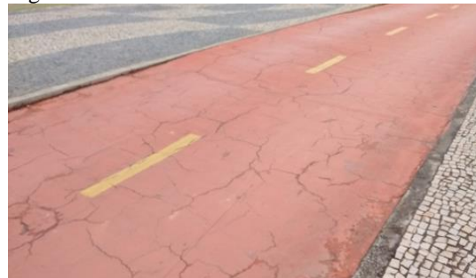
Figura 14a. Trecho de ciclovia com desnível.
