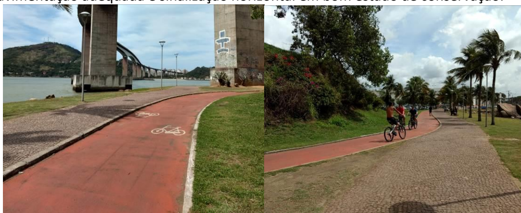
Figura 11 - Ciclovia da rua Marília de Rezende Scarton Coutinho na Ilha do Boi, com pavimentação adequada e sinalização horizontal em bom estado de conservação.
