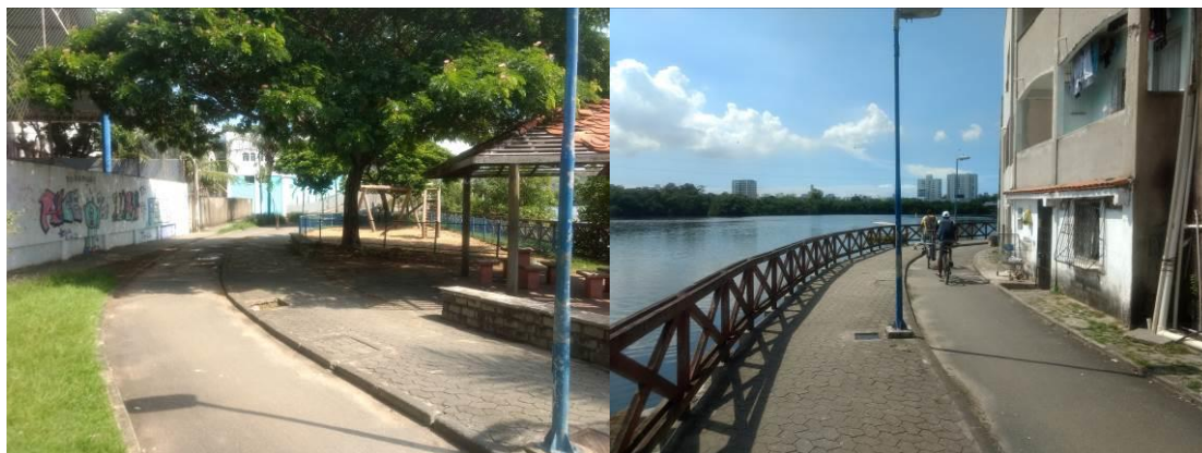
Figura 17 - Ciclovias às margens do rio Santa Maria. Ciclovias adequadas ao fluxo de ciclistas.
