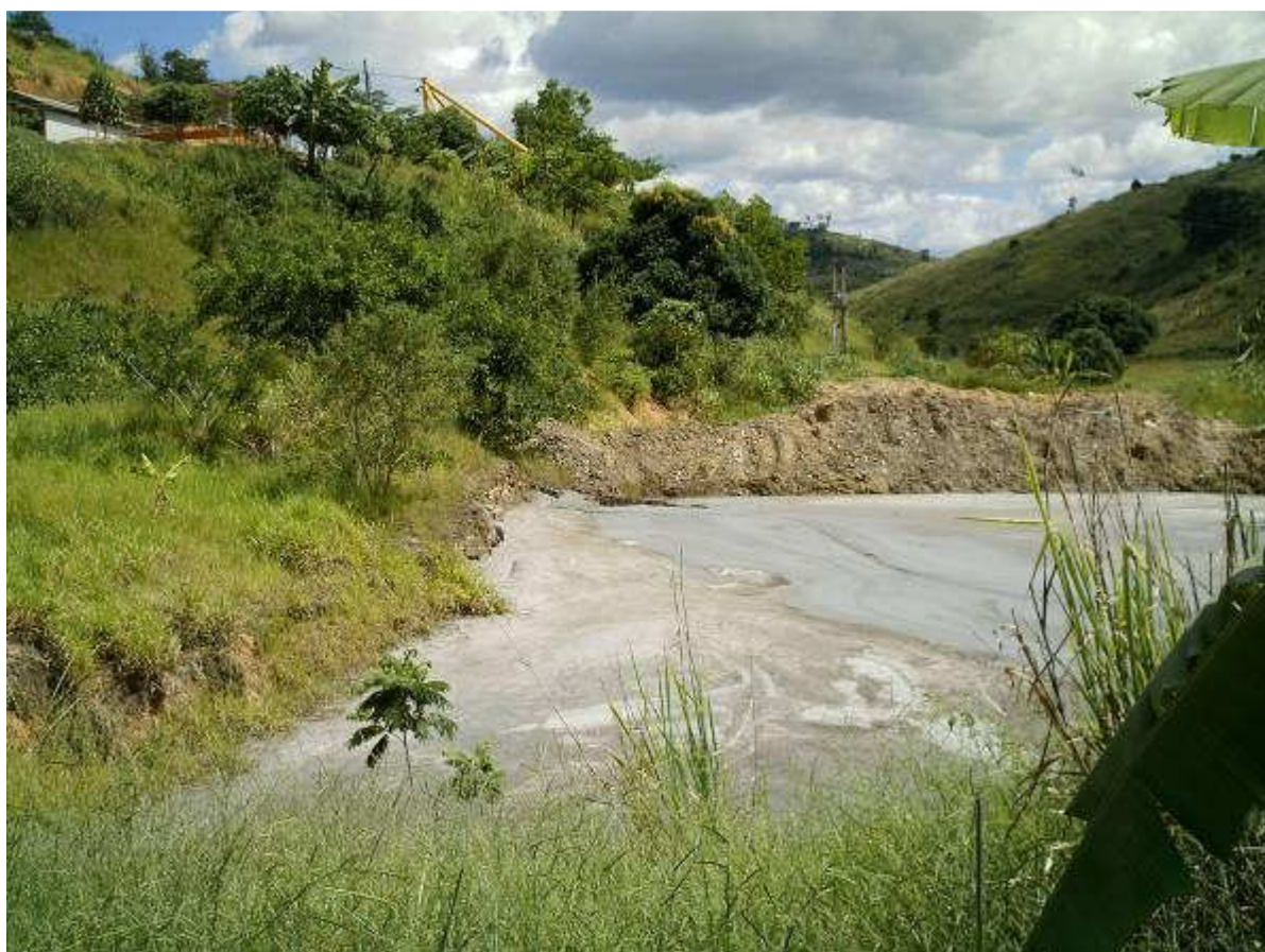
Foto 27: Barragem para captura, armazenamento e alocação da emissão dos efluentes da Serraria 02, no médio Córrego do Itá.
