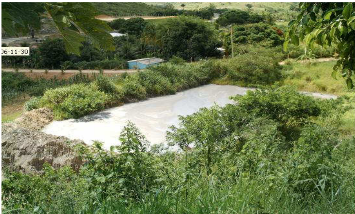
Foto 10: Tanque de decantação de resíduos provenientes da serragem do granito oriundo de serraria localizada no médio curso do Córrego do Itá, Barra de São Francisco - ES.
